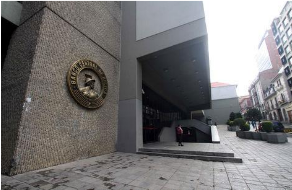
Frontis del edificio del Banco Central de Bolivia (BCB) en La Paz. Foto: La Razón
